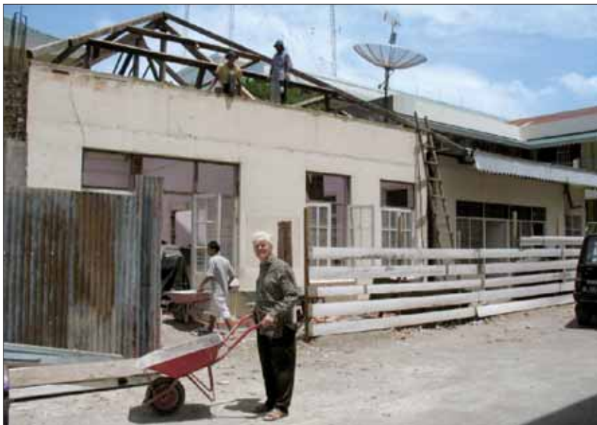
P. Ferdinando al lavoro per ristrutturare la casa parrocchiale
